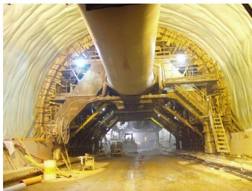
Foto 1: impalcato mobile su binari
