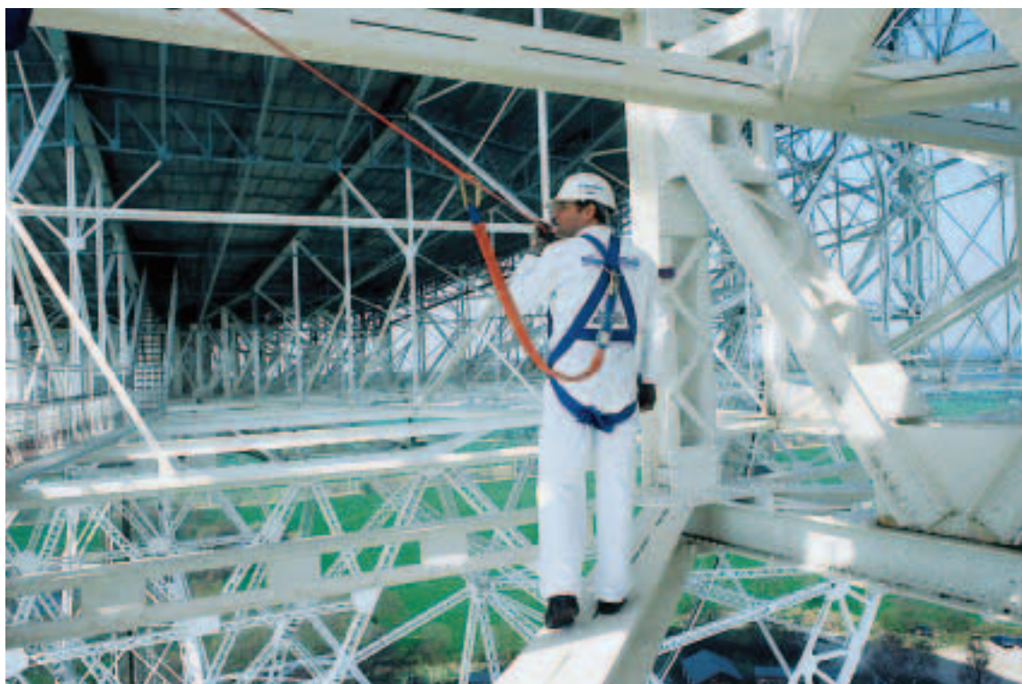
Figura 8: per eseguire i lavori in altezza è indispensabile non soffrire di vertigini e aver buon senso dell'equilibrio.
